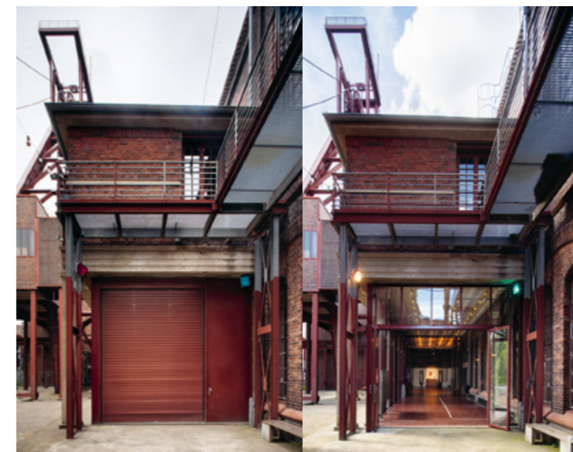
Umbau der Anlieferung von PACT Zollverein, Fotos: Dirk Rose
